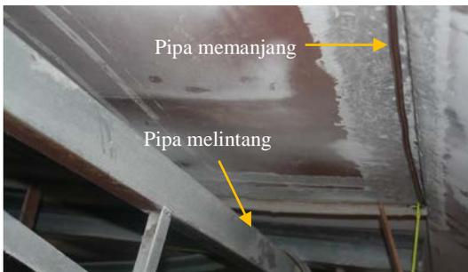
Gambar 4. Pemasangan pipa SB2 (kanan kapal).
