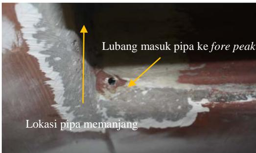
Gambar 3. Persiapan letak pipa SB3 (kiri kapal).
